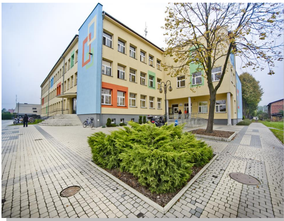
Budynek Zespołu Szkół
