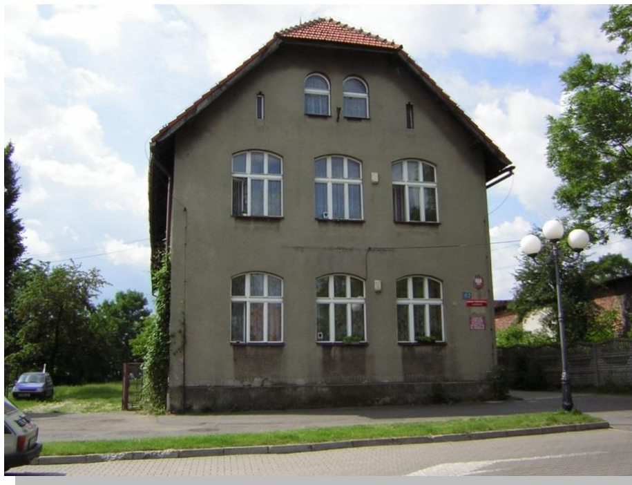
Budynek Gminnego Ośrodka Pomocy Społecznej
